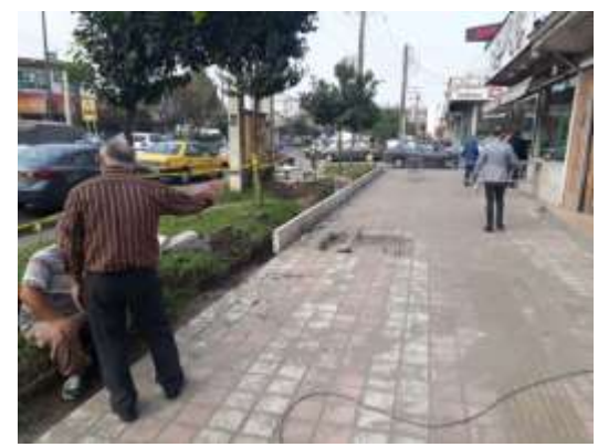
عکس بعد از اجرا
