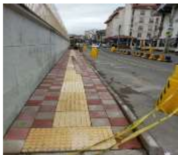
عکس بعد از اجرا
