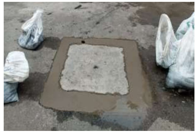
عکس بعد از اجرا
