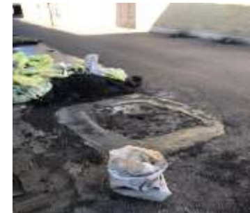
عکس بعد از اجرا
