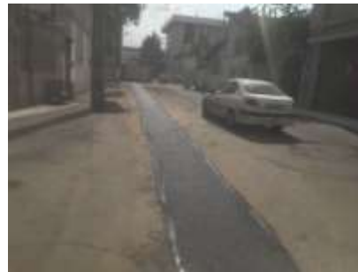
عکس بعد از اجرا
