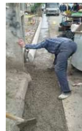
عکس بعد از اجرا
