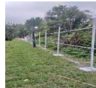
عکس بعد از اجرا
