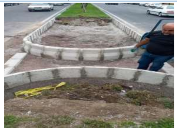
عکس بعد از اجرا
