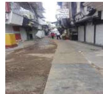
عکس بعد از اجرا
