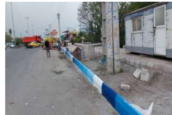
عکس بعد از اجرا
