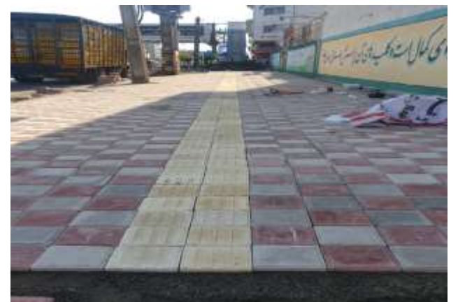
عکس بعد از اجرا
