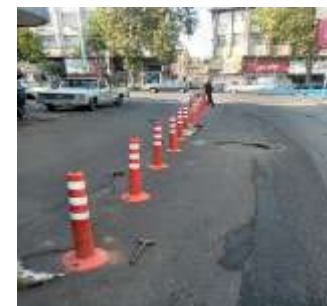
عکس بعد از اجرا
