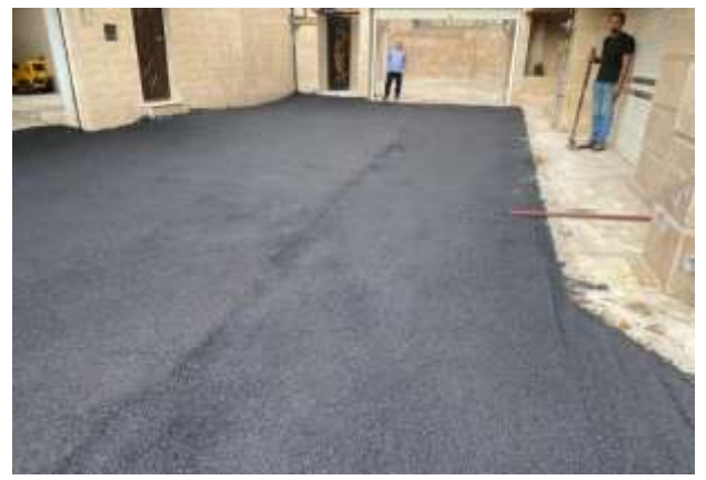
عکس بعد از اجرا
