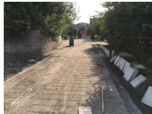
عکس بعد از اجرا
