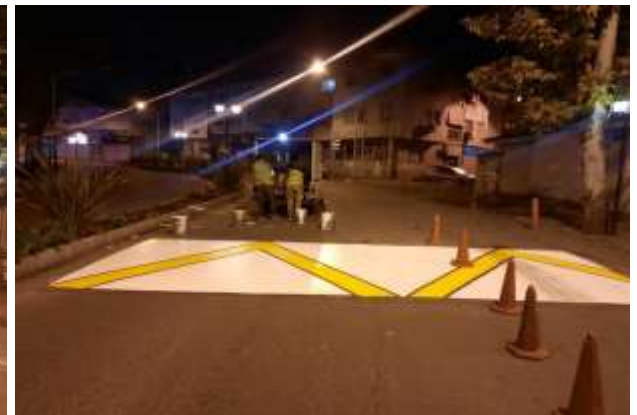
عکس بعد از اجرا
